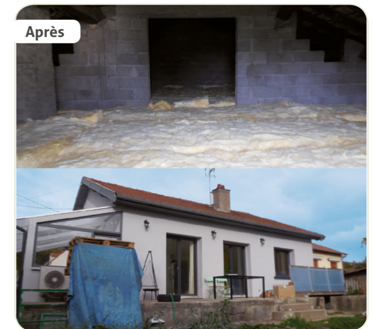
Dossier en 2015, d'un propriétaire occupant, comprenant : isolation des combles perdus, isolation des murs par l'intérieur, et changement des menuiseries.
