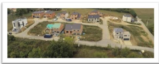
Le lotissement du Petit Verger vu du dessus.
