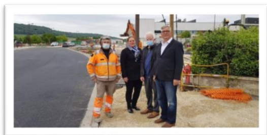
Une visite sur le chantier du rond-point de la Filoche.
