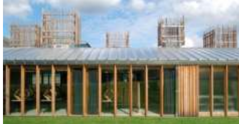
Exemple d'intégration architecturale d'éléments techniques tels que sorties de ventilation, puits de lumières...en toiture
