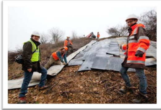
Opération délicate de bâchage des talus. ()
