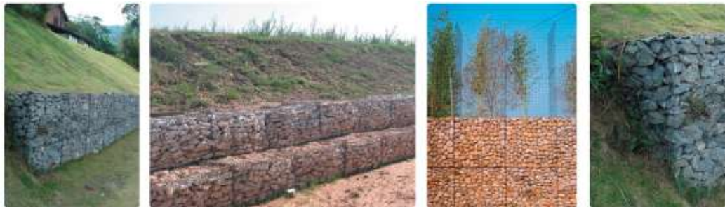
Exemples de gabionnage utilisés pour les affouillements
