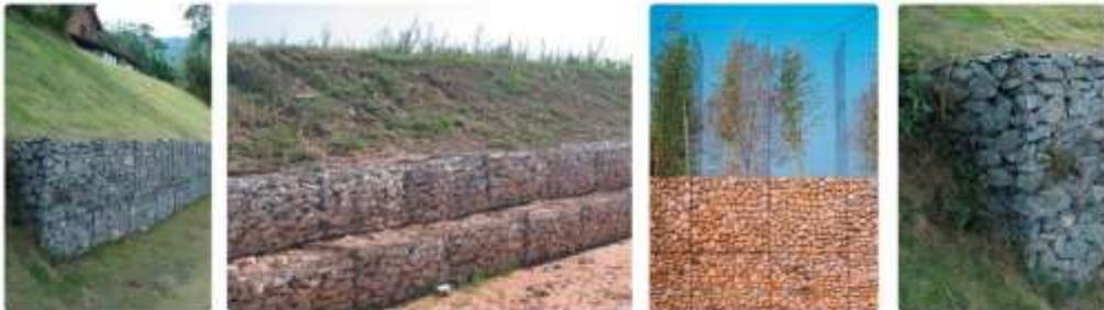
Exemples de gabionnage utilisés pour les affouillements
