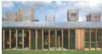
Exemple d'intégration architecturale d'éléments techniques tels que sorties de ventilation, puits de lumières... en toiture Collège Charlet _ Remiremont - Haha architectes
