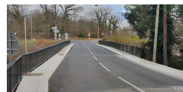
70 mètres de garde-corps terminent enfin le pont des Turbines.
