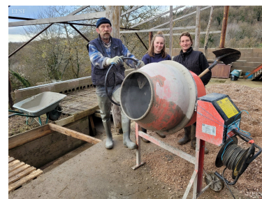
« Michou », Charlotte, l'apprentie « rayon de soleil » et Amandine ont entrepris de couler la chape du futur quai de traite. Les jeunes femmes ont trimballé 9 tonnes de sable et 50 sacs de 25 kg de ciment. Photo ER
