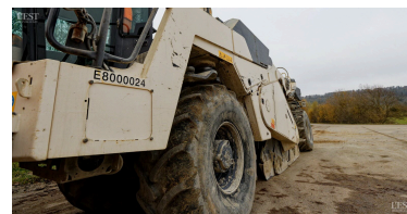
Réfection des chemins.
