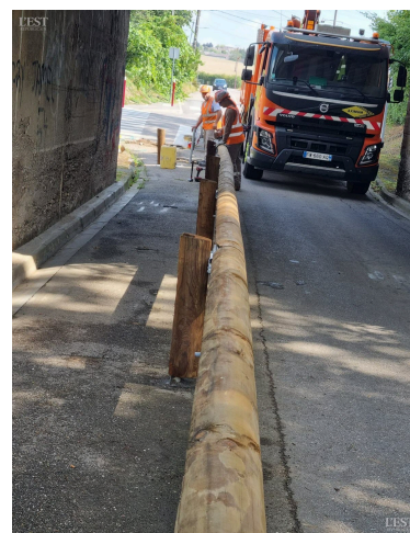
Réfection totale de la glissière de sécurité en bois sous le pont SNCF.
