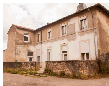
L'arrière de la future MAM avant les aménagements prévus : véranda et jardin d'enfants.
