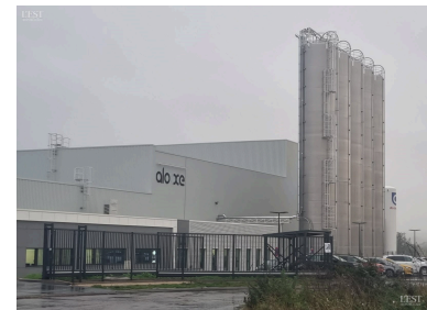
La société Aloxe a implanté dans le parc sa nouvelle usine de production de PET recyclé. La plus grande de France. Photo Jean-Christophe Vincent
