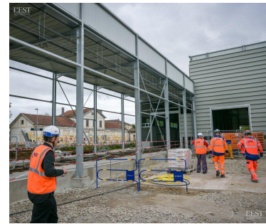
Le chantier de la ligne ferroviaire 14 et de la construction du bâtiment de maintenance et de remisage de la ligne est en cours. Photo Jérôme Humbrecht
