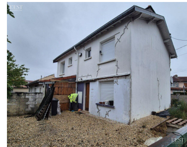
Cette maison du quartier d'Haussonville porte les stigmates de retraits et gonflements argileux. Photo Aymeric Humbert
