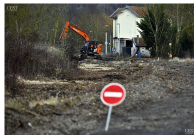
À Ceintrey, dans le Saintois, les grues sont à l'ouvrage pour retirer les vieux rails et traverses de la ligne 14 devant l'ancienne gare. Photo Alexandre Marchi
