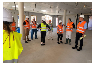
Michaël Placidi, l'architecte qui dirige le chantier, apporte des explications aux visiteuses et visiteurs de la mairie et de MMH. Photo Françoise Holweck
